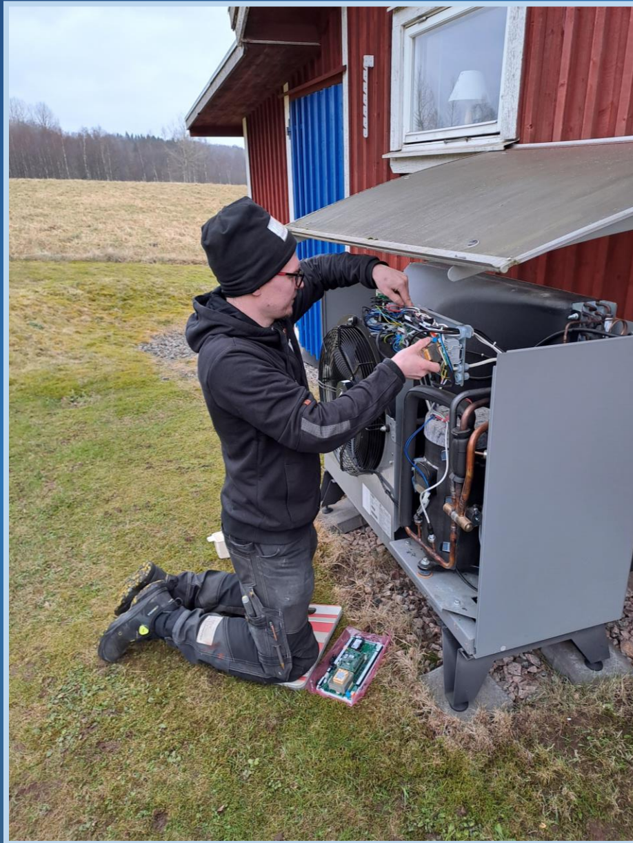
29.Feb Tobias tauscht die (blitzschlaggeschädigte?) Steuerungseinheit der Wärmepumpe aus.
