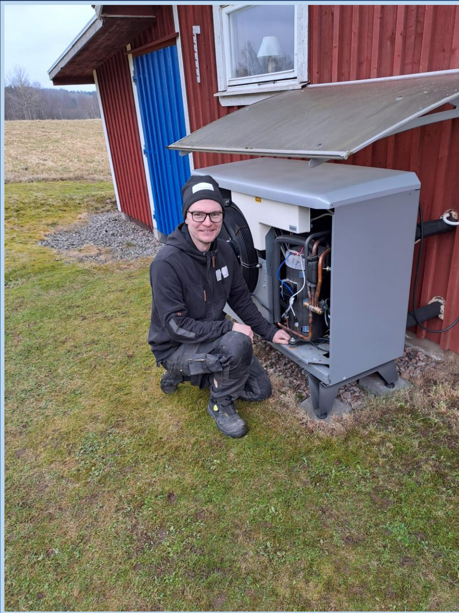
29.Feb Tobias tauscht die (blitzschlaggeschädigte?) Steuerungseinheit der Wärmepumpe aus.
